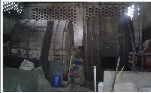
Foto No. 3 Bombos de proceso húmedo sin funcionamiento.
